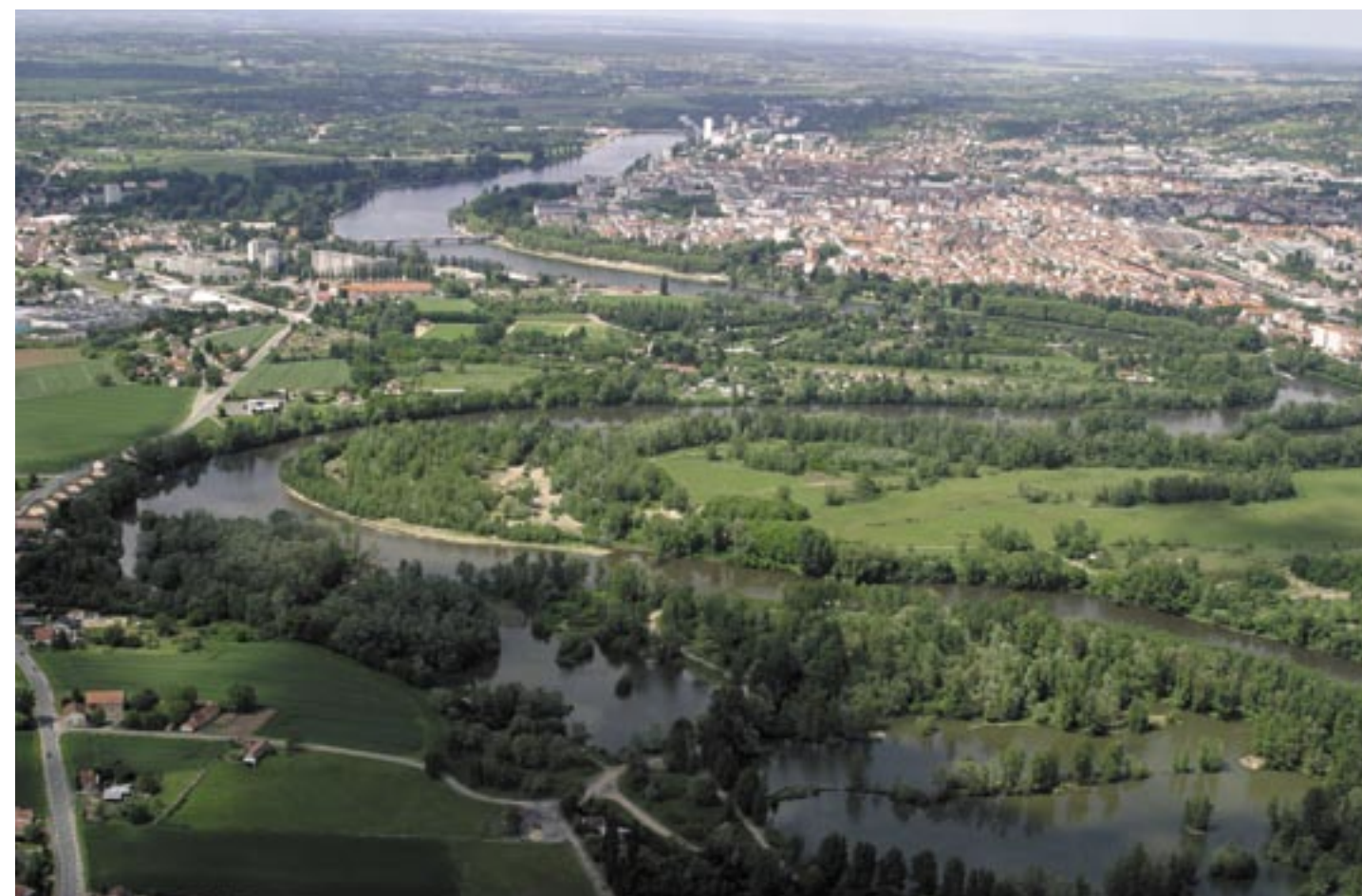
Vue aérienne du site - Y. Le Chapelin
